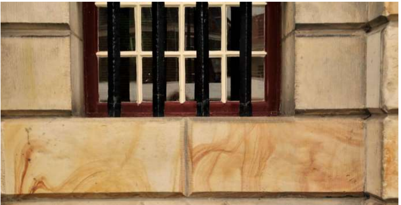
Liesegangse ringen in zandsteen.
